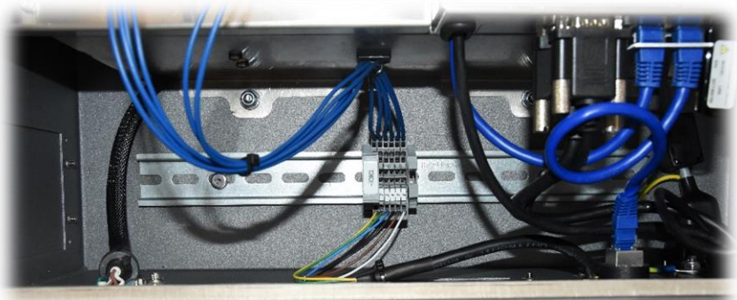
Abbildung 18: Montage Hutschiene mit Klemmleiste
